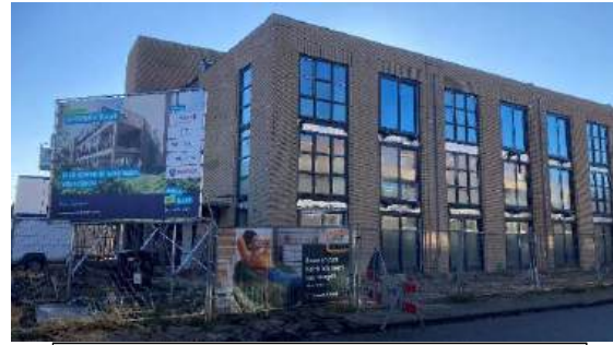
Project Grebbestraat (Beverwijk) in aanbouw
