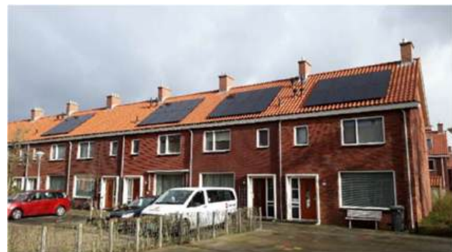
Zonnepanelen op de eengezinswoningen Muziekburch Heemskerk.
